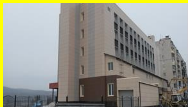
Завершающий этап реконструкции
