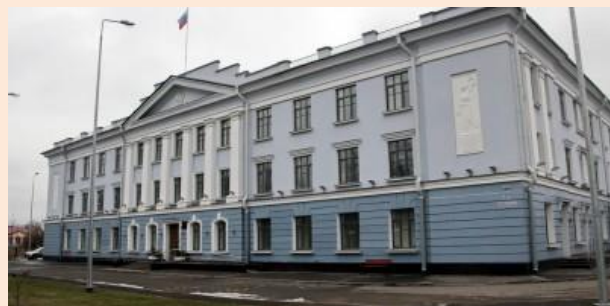
Строительство здания Колпинского районного суда г. Санкт-Петербурга (введено в эксплуатацию в 2013 г.)
