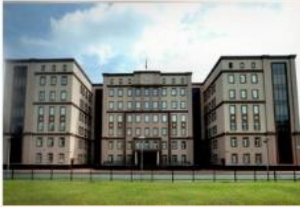
Строительство здания Выборгского районного суда г. Санкт-Петербурга (введено в эксплуатацию в 2013 г.)
