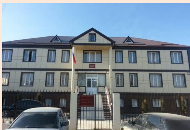
Строительство здания Левашинского районного суда в с. Леваша Республики Дагестан (введено в эксплуатацию в 2013 г.)
