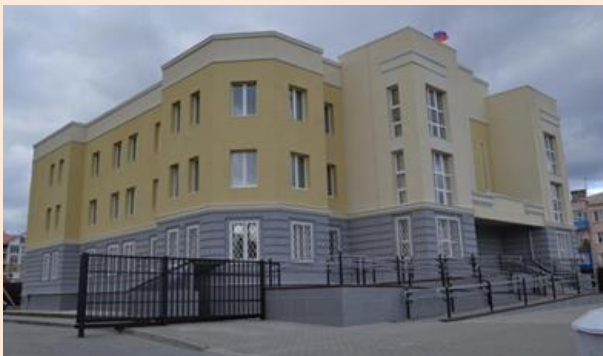
Строительство здания Лискинского районного суда Воронежской области (введено в эксплуатацию в 2015 г.)
