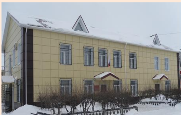
Реконструкция здания Исилькульского районного суда Омской области (введено в эксплуатацию в 2014 г.)
