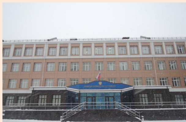
Кировский районный суд г. Екатеринбурга Свердловской области (планируется ввод в эксплуатацию в 2016 г.)
