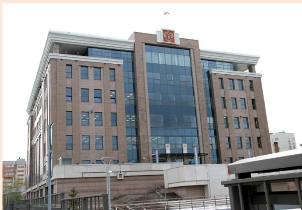
Строительство здания Арбитражного суда Республики Татарстан (введено в эксплуатацию в 2016 г.)
