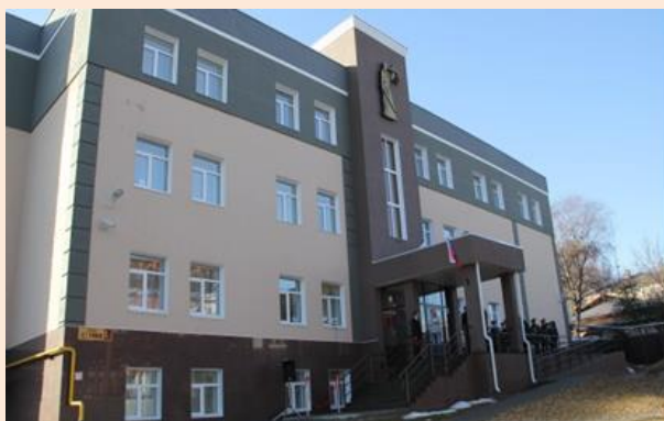
Реконструкция объекта незавершенного строительства, пристройка к зданию Ивановского гарнизонного военного суда (введено в эксплуатацию в 2014 г.)
