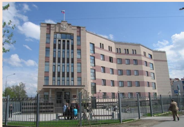
Строительство здания Невского районного суда г. Санкт-Петербурга (введено в эксплуатацию в 2013 г.)
