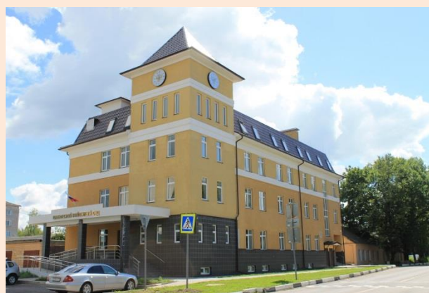
Строительство здания Шаховского районного суда Московской области (введено в эксплуатацию в 2013 г.)
