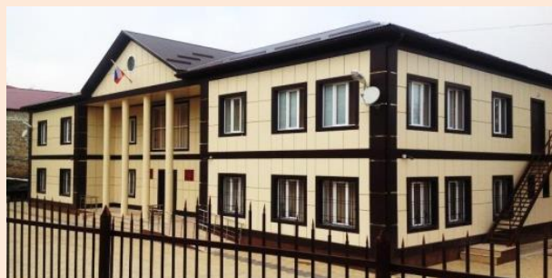
Строительство здания Сергокалинского районного суда в с. Сергокала Республики Дагестан (введено в эксплуатацию в 2013 г.)
