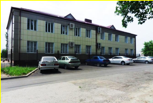
Здание Майского районного суда
