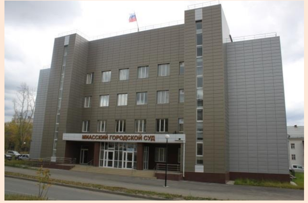
Строительство здания Миасского городского суда Челябинской области (введено в эксплуатацию в 2015 г.)
