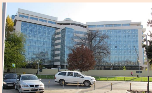
Строительство здания Арбитражного суда Краснодарского края (планируется ввод в эксплуатацию в 2016 году)
