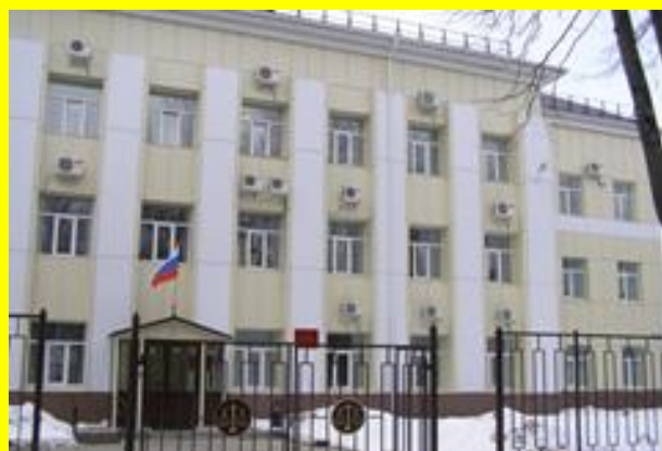
Введено в эксплуатацию после проведения комплексного капитального ремонта в 2015 г.
