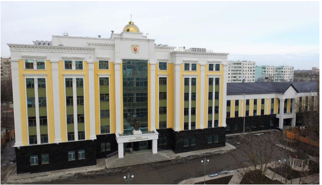
Здание Южного окружного военного суда
