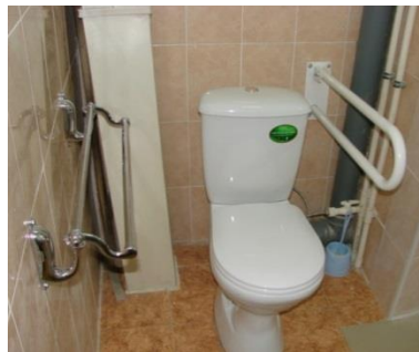
В рамках выборочного капитального ремонта выполнена работа по переоборудованию санитарного узла для МГН в Нюргинском городском суде Республики Саха (Якутия)
