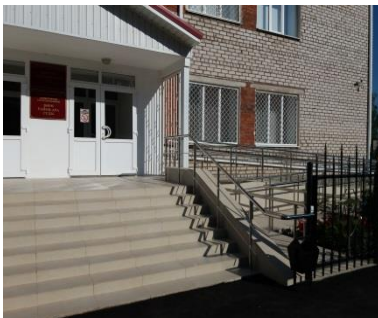
Переоборудован пандус на входе в здание Бирского межрайонного суда Республики Башкортостан
