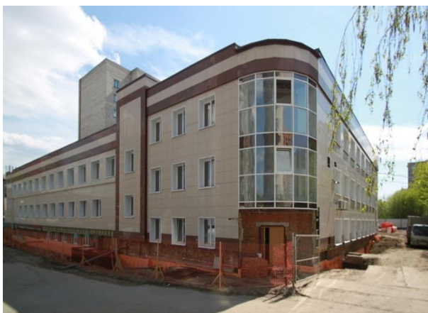
Строительство здания Первомайского районного суда г. Новосибирска
