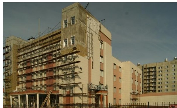
Строительство здания Нижнекамского городского суда Республики Татарстан
