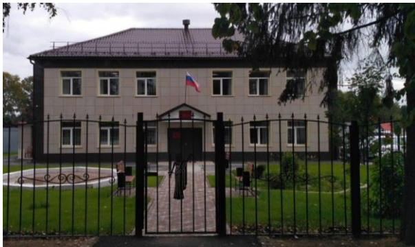
Здание Чердынского районного суда Пермского края
