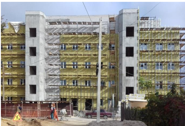
Строительство здания Городецкого городского суда Нижегородской области
