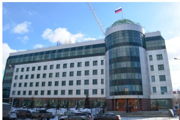
Здание Верховного Суда Республики Башкортостан (комплексная проверка Управления Судебного департамента в Республике Башкортостан в 2017 году)
