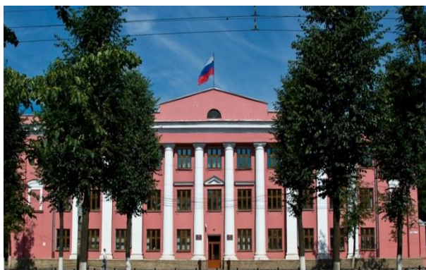
Здание Арбитражного суда Ярославской области (комплексная проверка Управления Судебного департамента в Ярославской области в 2017 году)
