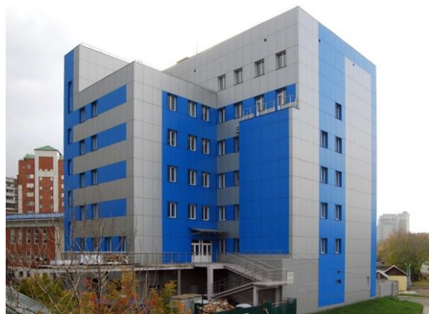
Строительство здания Центрального районного суда г. Красноярск
