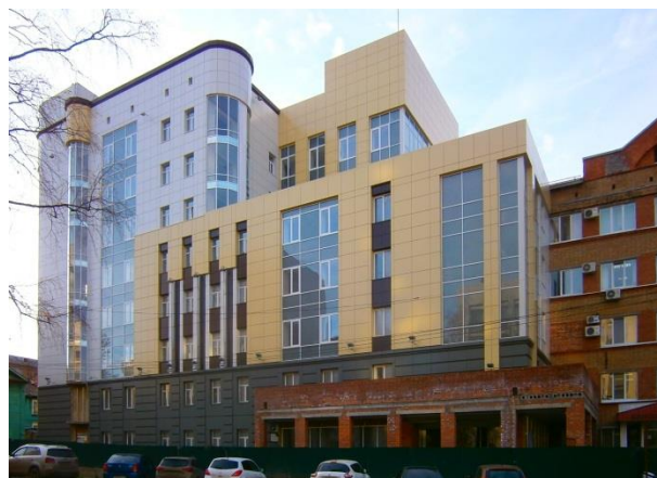
Строительство пристройки здания Сыктывкарского городского суда Республики Коми
