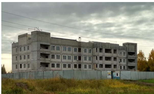
Строительство здания Набережночелнинского городского суда Республики Татарстан
