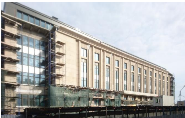
Строительство здания Арбитражного суда города Санкт-Петербурга и Ленинградской области
