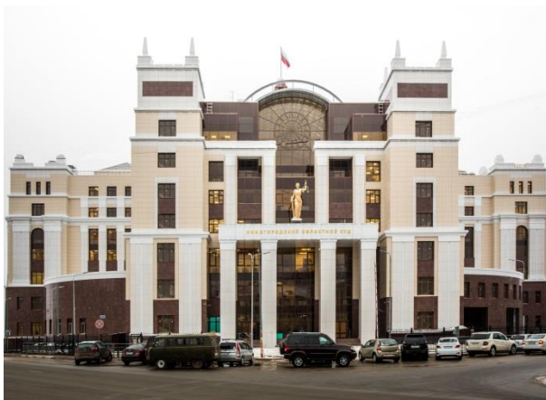
Строительство здания Нижегородского областного суда
