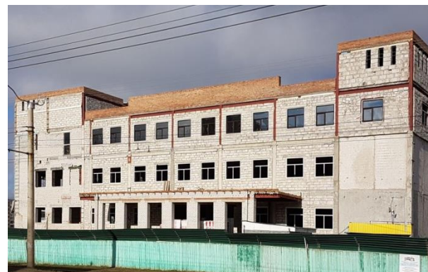
Приобретение и реконструкция здания для размещения Индустриального районного суда, г. Барнаул, ул. Балтийская. д. 28
