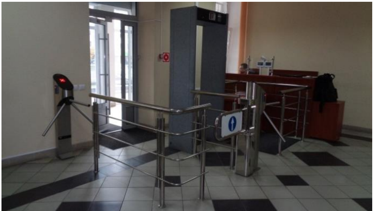
Пропускная система при входе в здание Ленинградского районного суда Калининградской области (комплексная проверка Управления Судебного департамента в Калининградской области в 2017 году)
