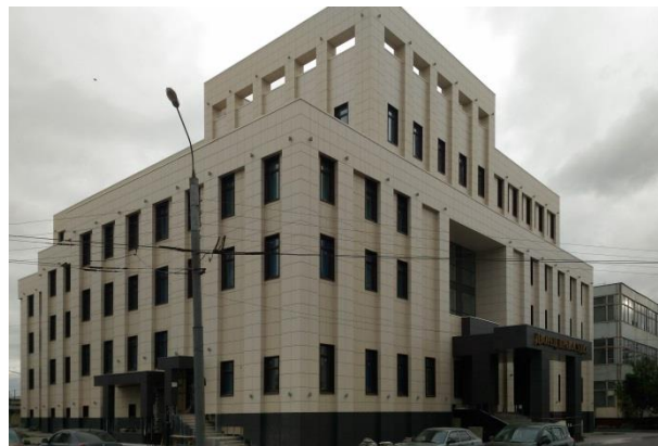
Строительство здания Автозаводского районного суда Нижегородской области
