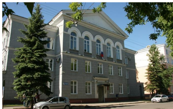
Здание Ленинского районного суда Ярославской области (комплексная проверка Управления Судебного департамента в Ярославской области в 2017 году)
