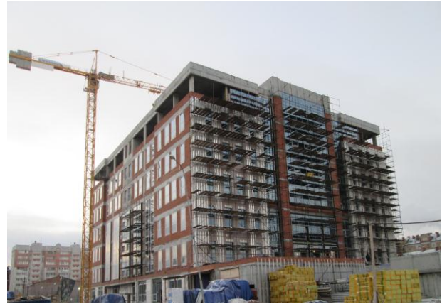
Строительство здания Арбитражного суда Республики Татарстан
