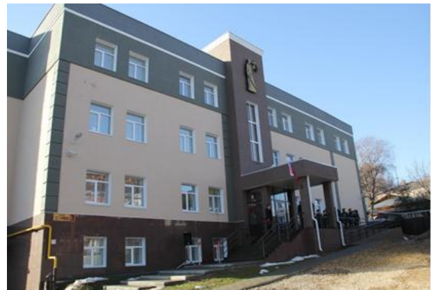
Пристройка к зданию Ивановского гарнизонного военного суда (реконструкция объекта незавершенного строительства, введено в эксплуатацию)
