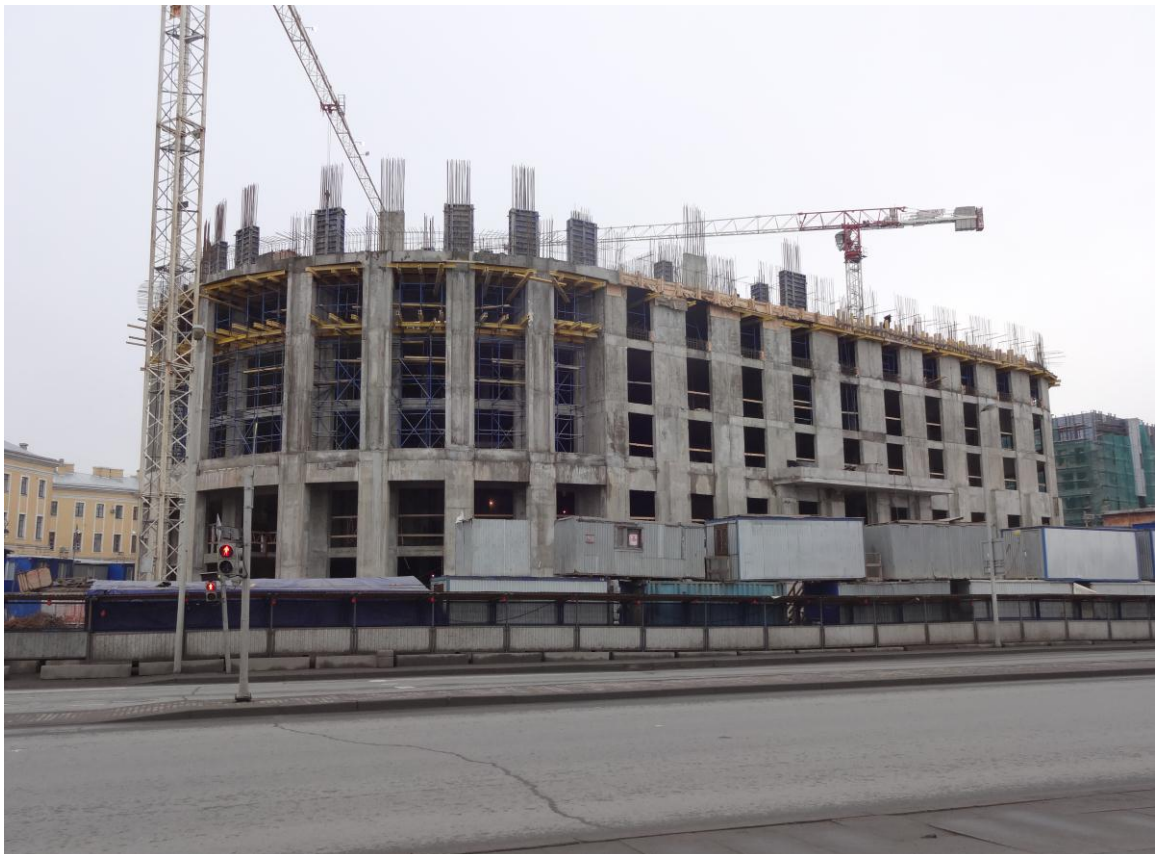
Строительство здания Арбитражного суда г. Санкт-Петербурга и Ленинградской области
