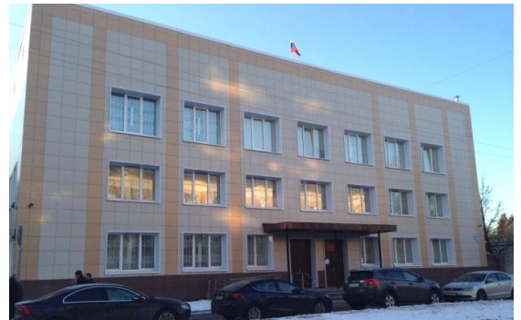
Здание Ломоносовского районного суда Ленинградской области
