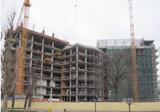
Строительство здания Арбитражного суда Краснодарского края
